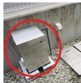
グリーストラップを恒常的に浄化するグリースオゾンナイザー
