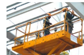
建設現場の高所作業車
