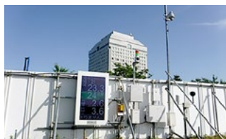
工事現場で活用される環境計測
